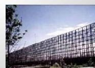
Barreira de Proteção de Vento (SAMARCO - ES)
