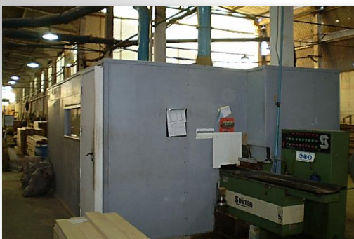
Sistema de enclausuramento
