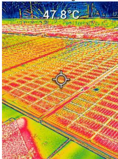
Figura 32 - Imagem térmica módulo 27.
