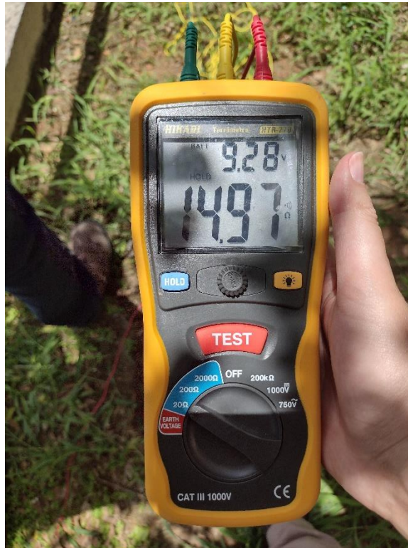
Figura 36 – Medição com o terrômetro da resistência de aterramento.
