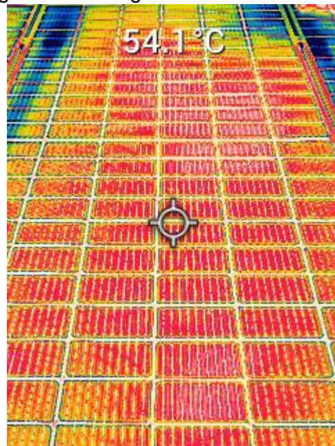
Figura 17 - Imagem térmica módulo 12.
