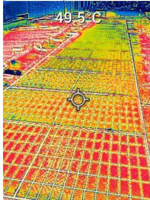
Figura 13 - Imagem térmica módulo 8.
