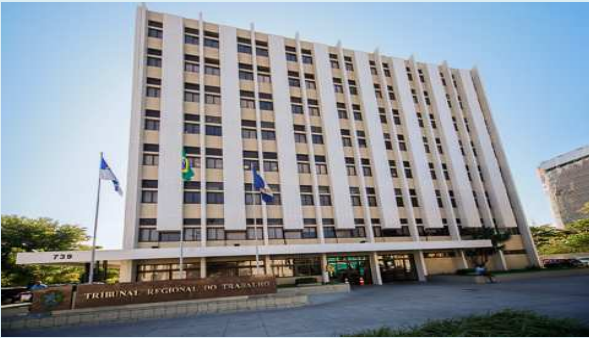
Edifício Sede / Anexos TRT/PE
