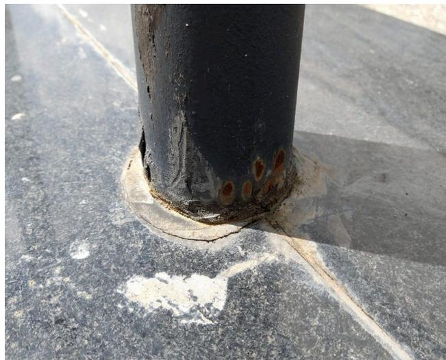
Fig. 06- Oxidação no pé do mastro (sem primer)
