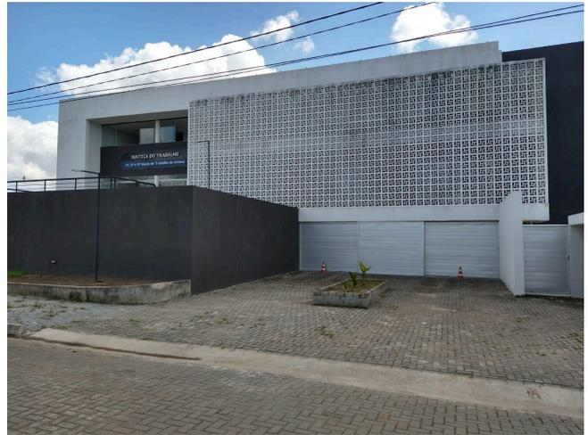
Fig. 18- Tipo do cobogó, que substituiu o AD-56, da
