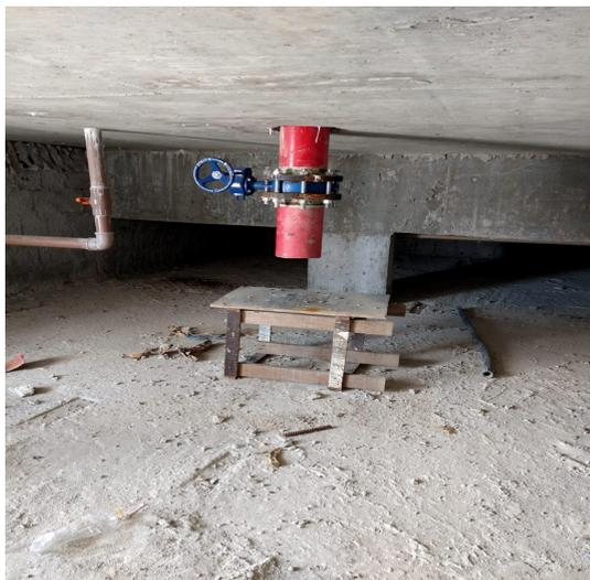
Fig. 05- Tubulação contra-incêndio interrompida
