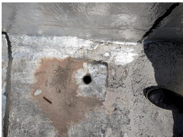
Fig. 01- Falhas de impermeabilização
