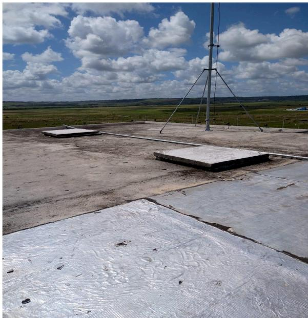
Fig. 03- Falta manta de impermeabilização
