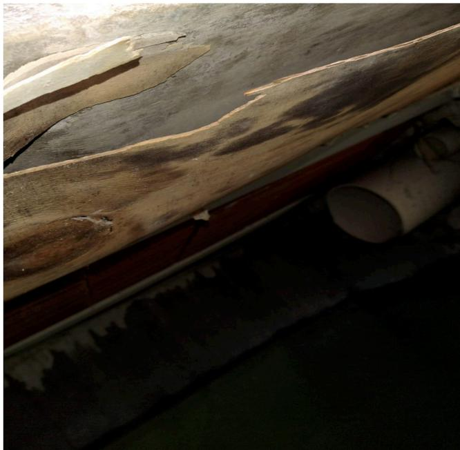
Fig. 19- Teto do reservatório inferior c/ resto de madeira
