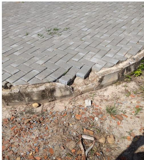
Fig. 24- Falha de confinamento em piso intertravados
