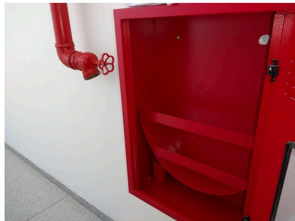
Fig. 08- Só o abrigo (sem mangueira e conexões)
