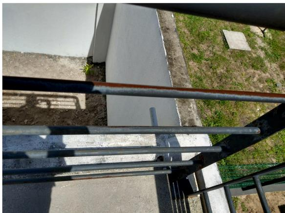
Fig. 09- Guarda-corpo oxidado (sem primer)
