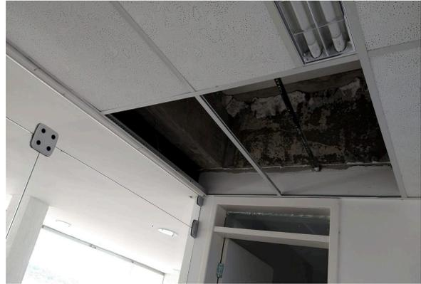
Fig. 12- Placas de forro faltando
