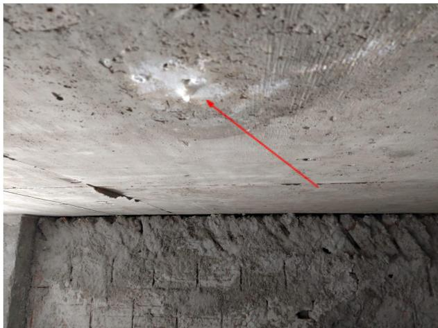
Fig. 07- Vazamentos do reservatório superior
