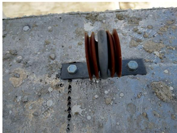
Fig. 10- Isolador de SPDA, furando a manta
