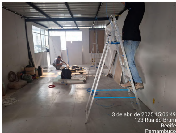
Foto 19: Instalações elétricas e rejuntamento de piso.
