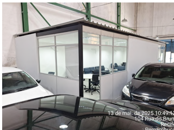
Foto 30: Vista externa do salão.
