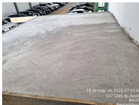
Foto 8: Laje da guarita - vista superior.
