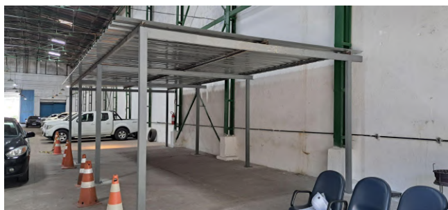
Foto 1: Estrutura metálica do salão e telhas.
