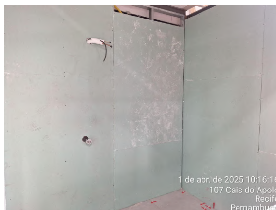
Foto 16: Paredes da guarita e instalação para split .
