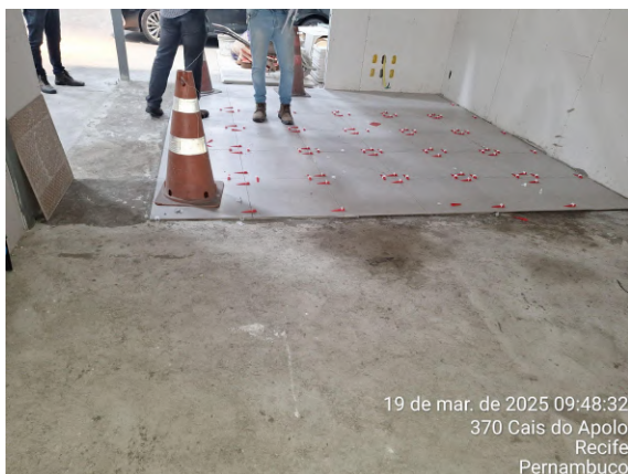
Foto 11: Início do assentamento do porcelanato.
