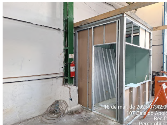
Foto 6: Estrutura metálica, paredes e laje.
