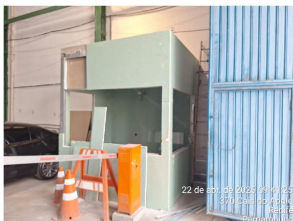
Foto 25: Fechamento das paredes da guarita.
