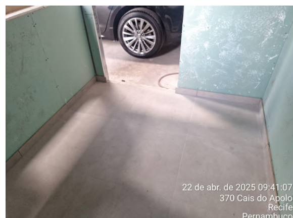
Foto 26: Piso da guarita concluído.
