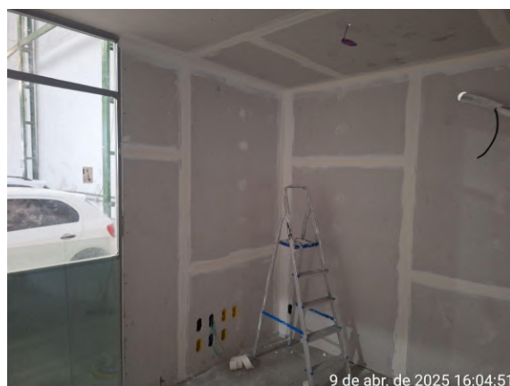
Foto 22: Rejuntamento das placas com fita anti-trinca.
