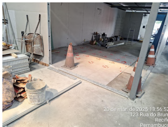
Foto 12: Assentamento de soleiras.
