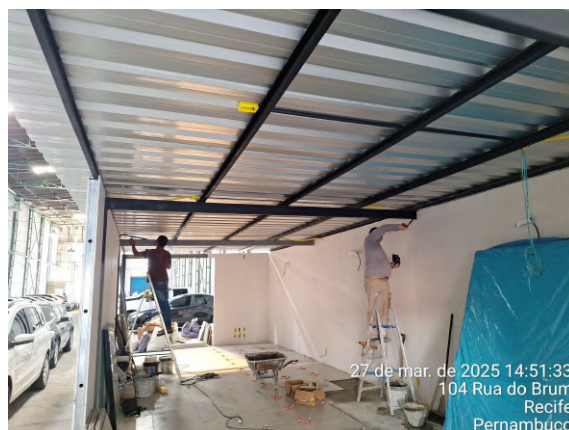
Foto 13: Instalações elétricas e pintura da estrutura.
