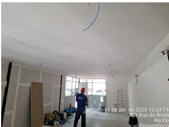
Foto 23: Emassamento de paredes e forro.
