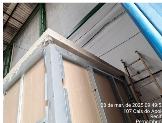
Foto 14: Vista da laje da guarita depois da desforma.
