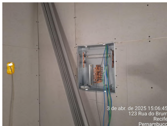
Foto 20: Quadro elétrico do salão em montagem.
