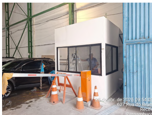
Foto 28: Retoques de pintura na guarita.
