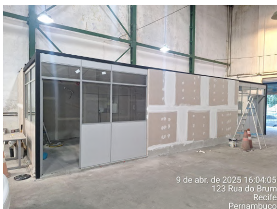
Foto 21: Rejuntamento das placas com fita anti-trinca.
