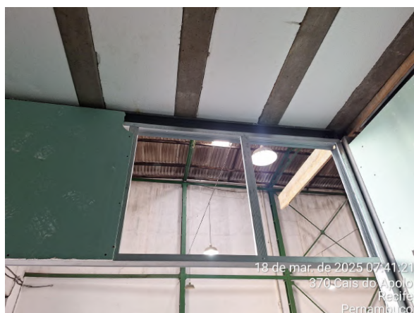
Foto 7: Laje da guarita - vista inferior.
