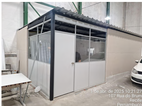
Foto 17: Instalação das divisórias.
