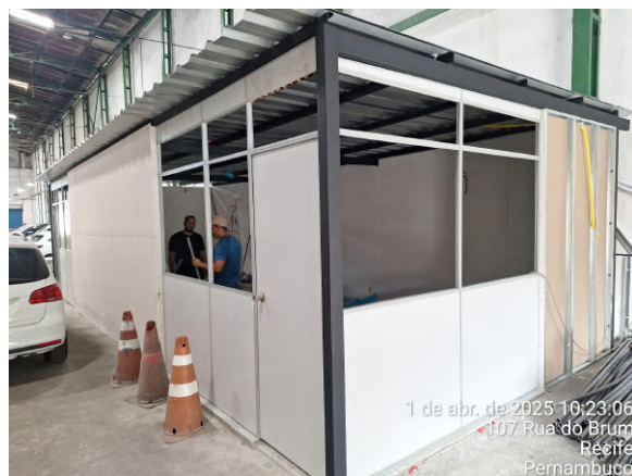
Foto 18: Instalação das divisórias.
