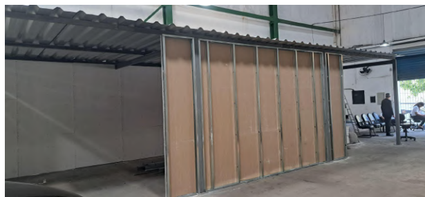
Foto 4: Início do fechamento das paredes em drywall.
