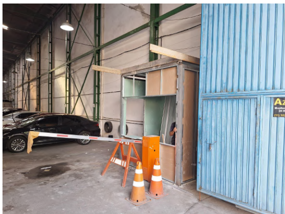
Foto 5: Estrutura metálica, paredes e laje.
