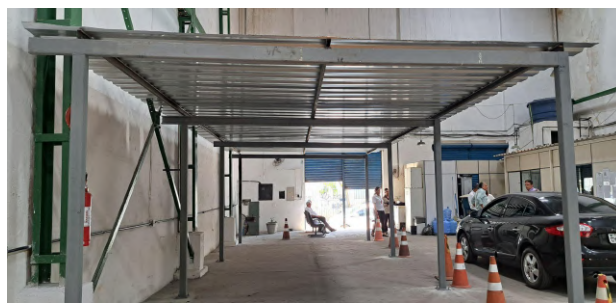
Foto 2: Estrutura metálica do salão e telhas.
