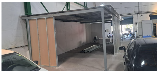
Foto 3: Início do fechamento das paredes em drywall.
