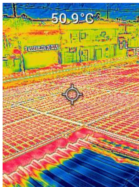
Figura 23 - Imagem térmica módulo 18.
