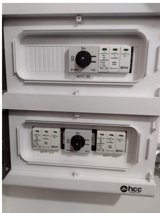
Figura 3 - Identificação das stringbox seguindo o projeto do inversor 1.
