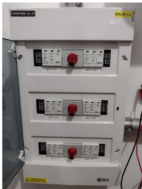
Figura 4 - Identificação das stringbox seguindo o projeto do inversor 2.
