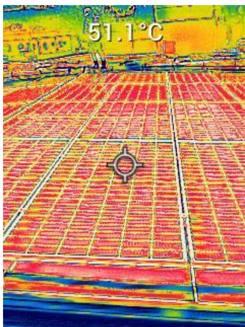
Figura 14 - Imagem térmica módulo 9.
