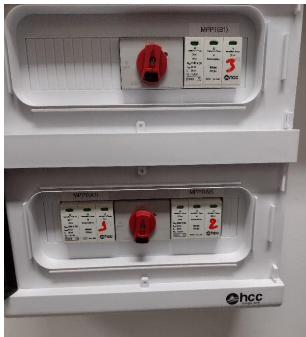
Figura 3 - Identificação das stringbox seguindo o projeto do inversor 1.
