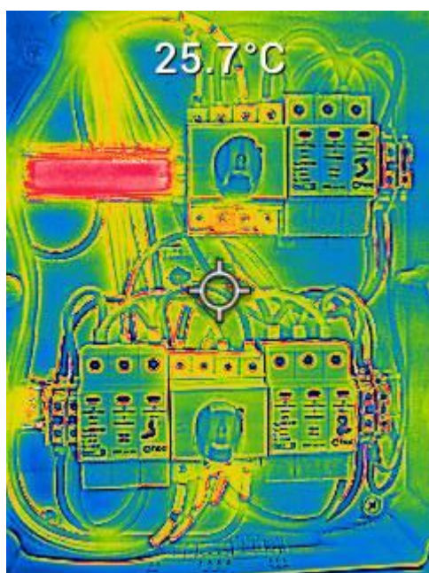
Figura 26 – Imagem com a câmera térmica da stringbox do inversor 1.
