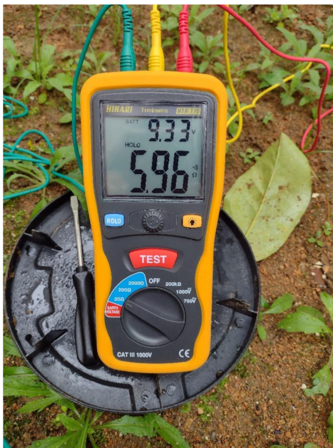
Figura 13 – Medição com o terrômetro da resistência de aterramento.
