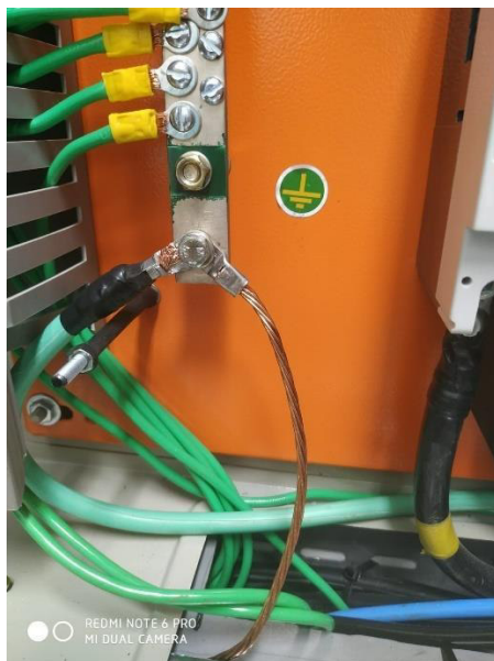
Figura 10 – Troca do cabo de aterramento para 16mm 2 .
