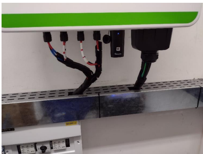
Figura 1 - Imagem do cabeamento da entrada CC do inversor 1.
