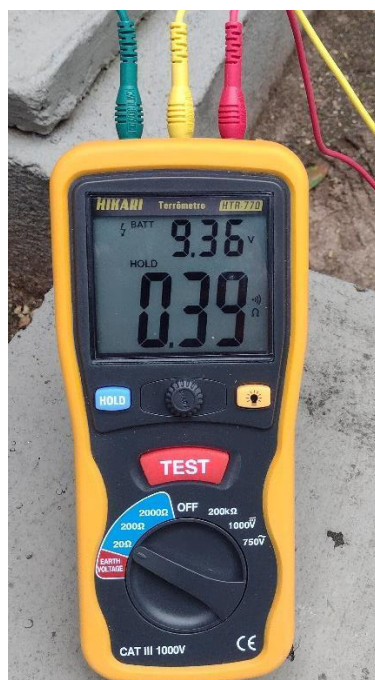
Figura 25 – Medição com o terrômetro da resistência de aterramento.
