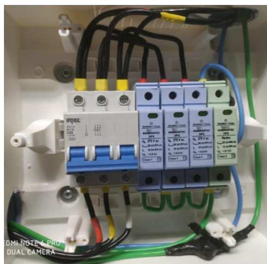
Figura 7- Cabeamento do neutro no DPS.
