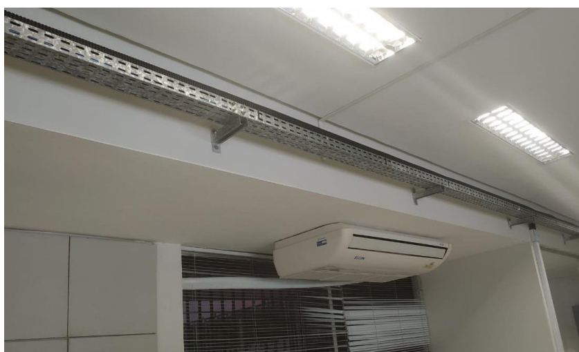
Figura 8 – Eletroduto corrugado separando os cabos do sistema solar na eletrocalha.
