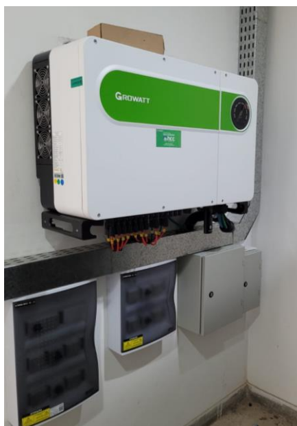
Figura 1- Imagem do cabeamento da entrada CC dos inversores.
