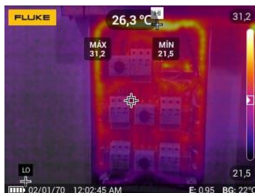
Figura 44 – Imagem com a câmera térmica da stringbox.
