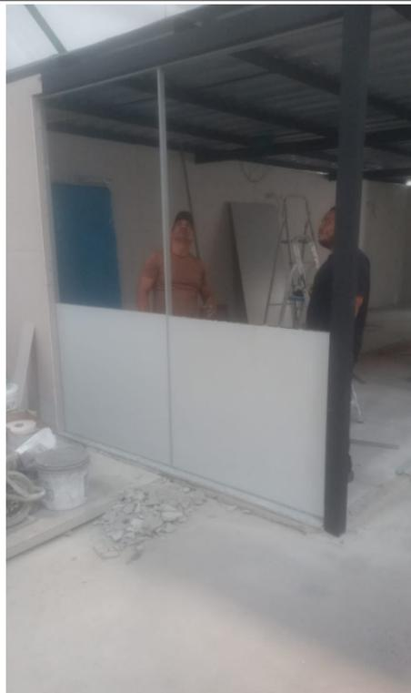
2.4 - FORNECIMENTO E INSTALAÇÃO DE DIVISÓRIA NAVAL TIPO EUCATEX, MODELO N4 (PAINEL/VIDRO/VIDRO) COM PERFIL DE AÇO
