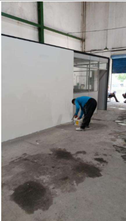
2.7 - EMASSAMENTO COM MASSA LÁTEX, APLICAÇÃO EM PAREDE, DUAS DEMÃOS, LIXAMENTO MANUAL. AF\_04/2023
