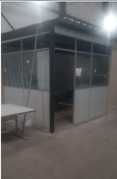
2.4 - FORNECIMENTO E INSTALAÇÃO DE DIVISÓRIA NAVAL TIPO EUCATEX, MODELO N4 (PAINEL/VIDRO/VIDRO) COM PERFIL DE AÇO
