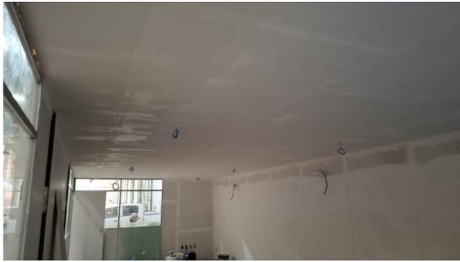
2.7 - EMASSAMENTO COM MASSA LÁTEX, APLICAÇÃO EM PAREDE, DUAS DEMÃOS, LIXAMENTO MANUAL. AF\_04/2023
