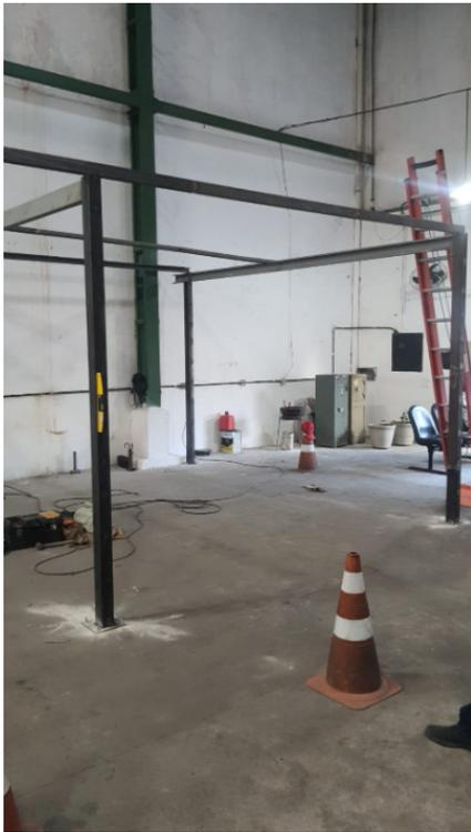
3.1 - FORNECIMENTO E INSTALAÇÃO DE TUBO INDUSTRIAL EM AÇO SAE, DIM 100X100 MM, E=2,00MM (
