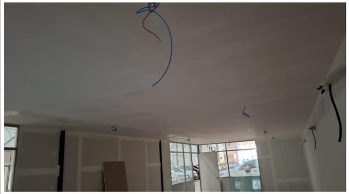
2.11 - EMASSAMENTO COM MASSA LÁTEX, APLICAÇÃO EM TETO, DUAS DEMÃOS, LIXAMENTO MANUAL. AF\_04/2023
