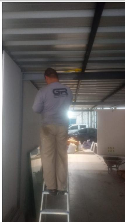
3.5 - PINTURA COM TINTA ALQUÍDICA DE ACABAMENTO (ESMALTE SINTÉTICO ACETINADO) APLICADA A ROLO OU PINCEL SOBRE PERFIL METÁLICO EXECUTADO EM FÁBRICA (POR DEMÃO). AF\_01/2020
