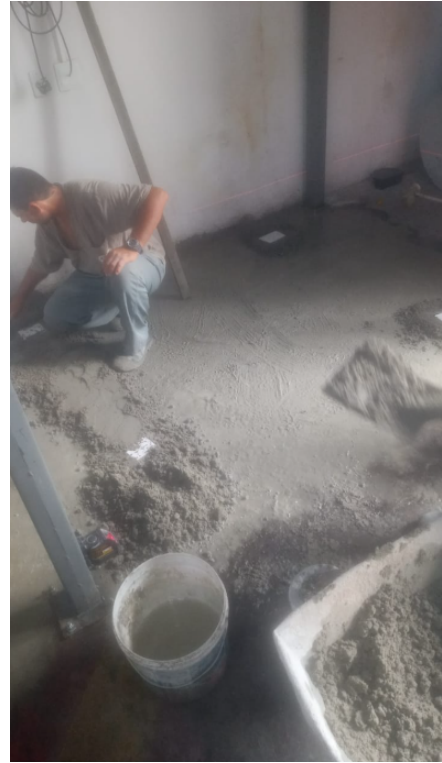
2.14 - CONTRAPISO EM ARGAMASSA TRAÇO 1:4 (CIMENTO E AREIA), PREPARO MANUAL, APLICADO EM ÁREAS SECAS SOBRE LAJE, ADERIDO, ACABAMENTO NÃO REFORÇADO, ESPESSURA 2CM. AF_07/2021
