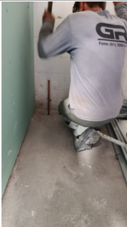
5.1.6 - HASTE DE ATERRAMENTO, DIÂMETRO 5/8", COM 3 METROS - FORNECIMENTO E INSTALAÇÃO. AF_08/2023
