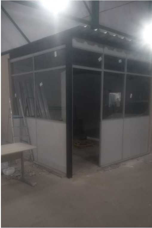
2.4 - FORNECIMENTO E INSTALAÇÃO DE DIVISÓRIA NAVAL TIPO EUCATEX, MODELO N4 (PAINEL/VIDRO/VIDRO) COM PERFIL DE AÇO
