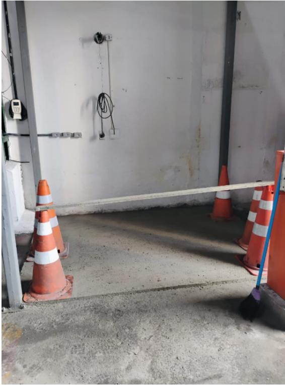
2.14 - CONTRAPISO EM ARGAMASSA TRAÇO 1:4 (CIMENTO E AREIA), PREPARO MANUAL, APLICADO EM ÁREAS SECAS SOBRE LAJE, ADERIDO, ACABAMENTO NÃO REFORÇADO, ESPESSURA 2CM. AF_07/2021
