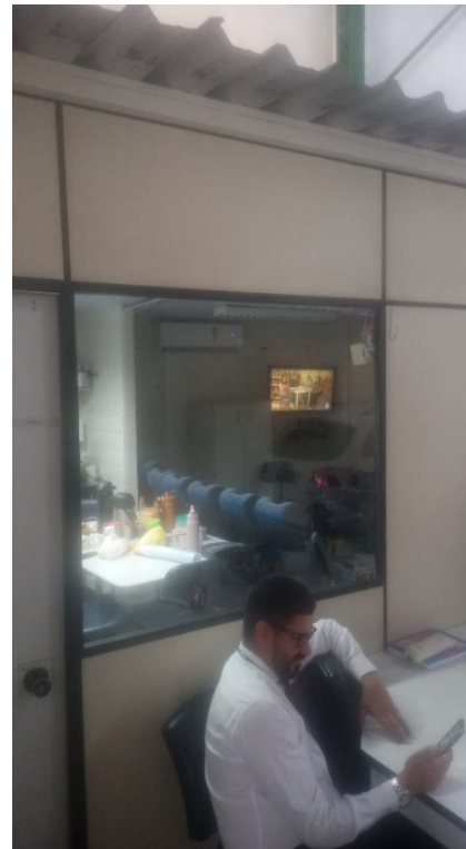
1.1 - RETIRADA DE DIVISÓRIA TIPO NAVAL
