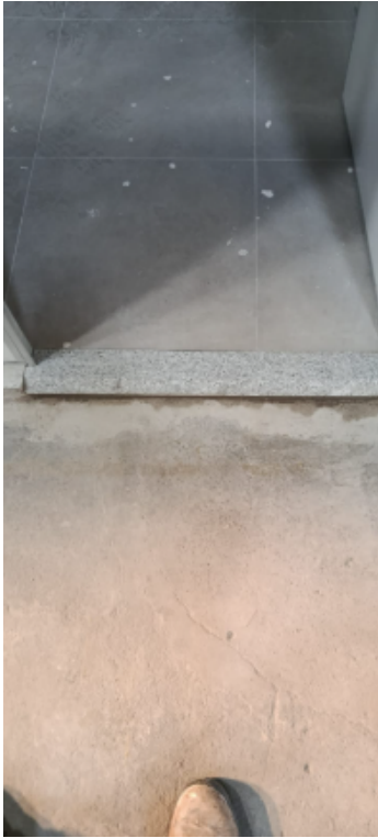
INSTALAÇÃO DAS SOLEIRAS
