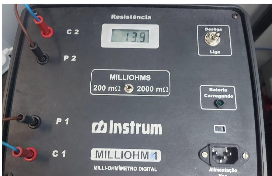
Figura 20 – Medição com o terrômetro da resistência de aterramento.
