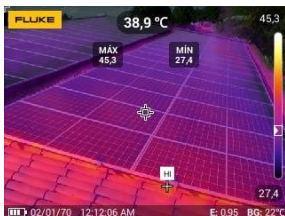
Figura 19 - Imagem térmica módulo 17.
