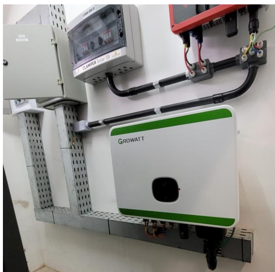
Figura 1 - Imagem do cabeamento da entrada CC dos inversores.
